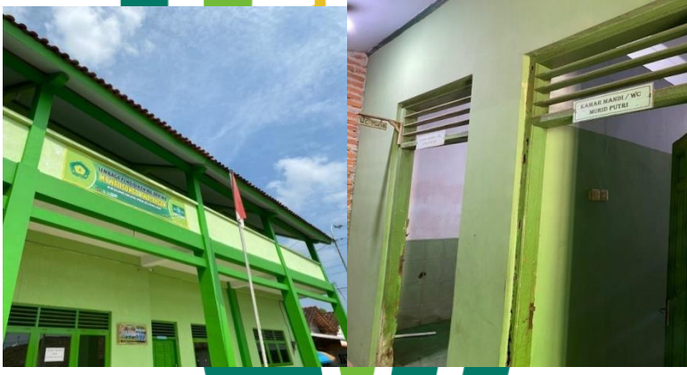
Gedung Kamar Mandi/Toilet
