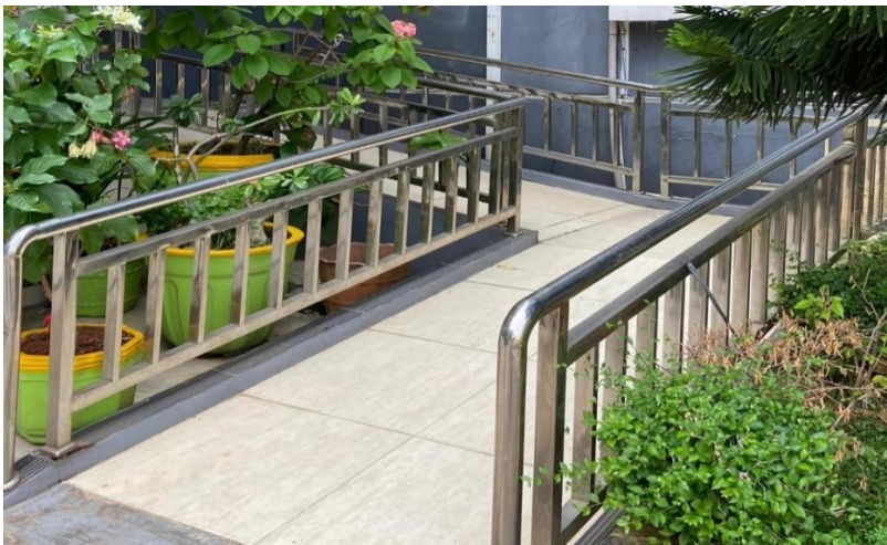
Akses jalanan ramah kursi roda di depan Gedung F kampus Universitas Pekalongan
