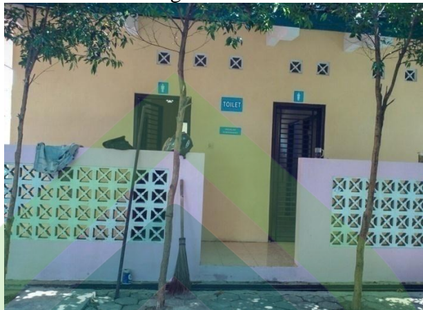
Toilet di Pasar Podosugih
