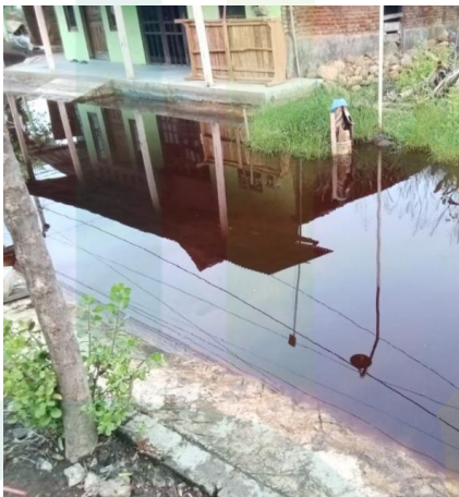
Dokumentasi Banjir di Dusun Njompo, Desa Karangjampo
