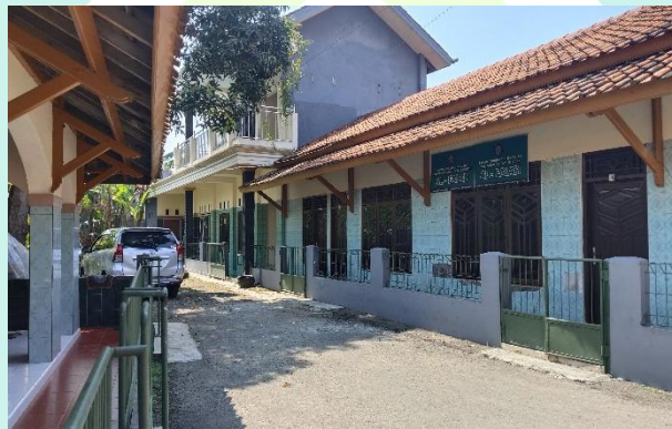
Dokumentasi Bangunan TPQ Al Falah Desa Rembun
