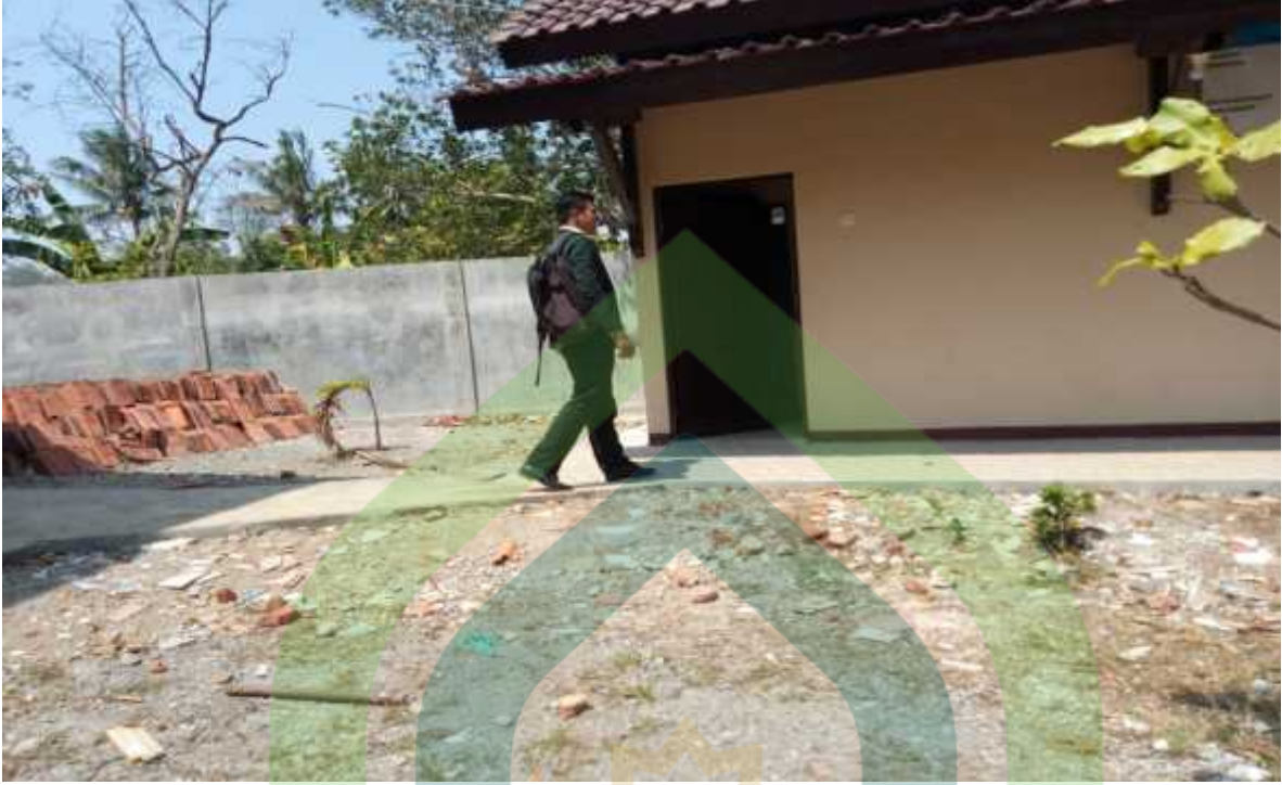
Kedaaan toilet Siswa-siswi di SMP Negeri 2 Kajen Kab.Pekalongan
