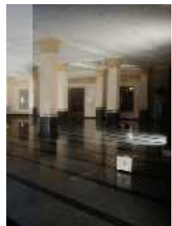
Gambar 3 tiang penyangga serambi masjid
