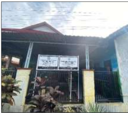
Gedung Bangunan Sekolah
