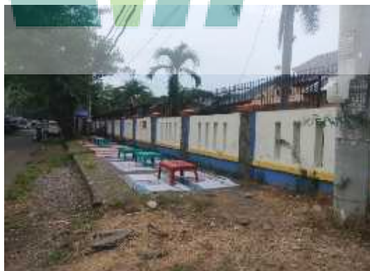
Gambar 3.3 Trotoar Jalan Paesan Utara Kedungwuni
