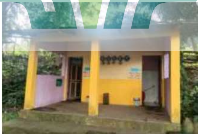
(Toilet Salah Satu Fasilitas Desa Wisata Cempaka)
