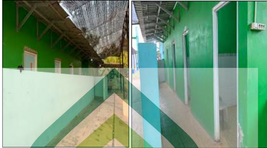
Gambar 4.5 Kondisi Toilet Kolam Renang Tirta Arum
