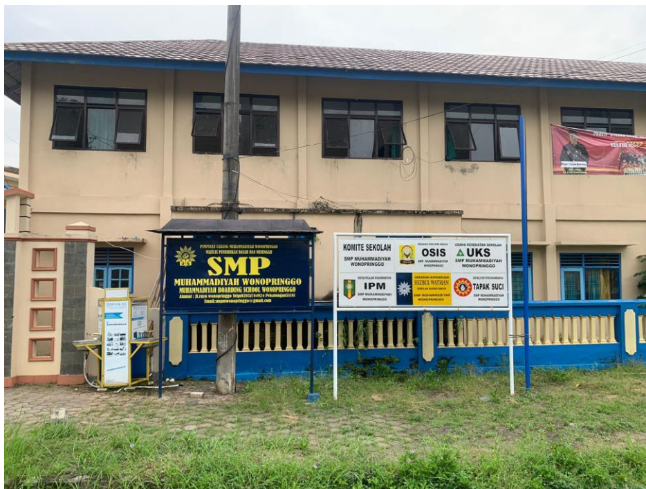
Gedung pondok pesantren Al-Hidayah Wonopringgo
