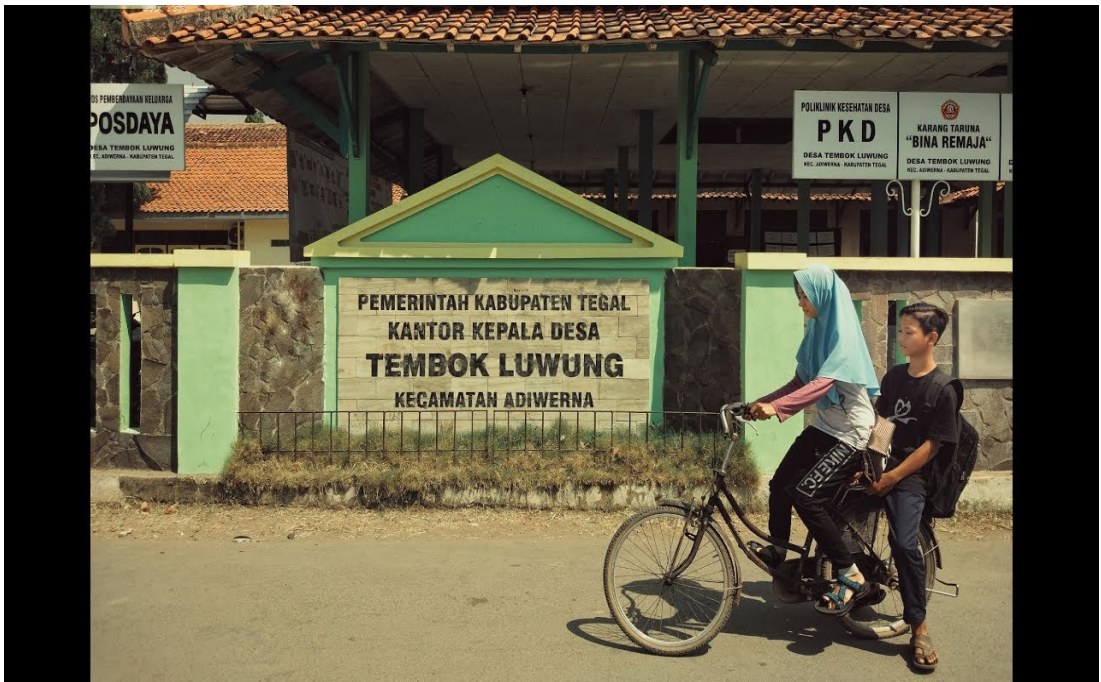
Gedung Balai Desa Tembokluwung Tampak Luar
