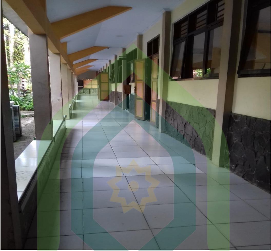
Ruang Kelas SMP Negeri 03 Pekalongan
