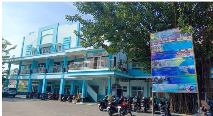
Depan Gedung SMK Satya Praja 2 Petarukan Pemasang
