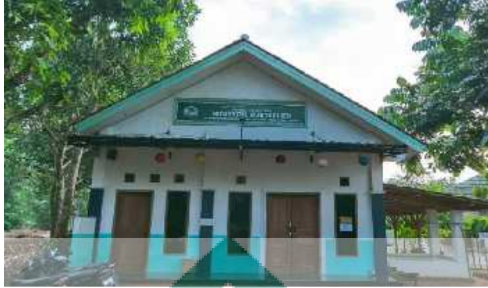
Dokumentasi Gedung Pondok Pesantren Hidayatul Muftadi-ien Bojong Pekalongan
